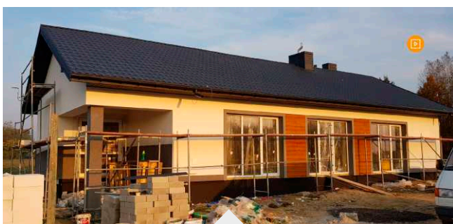
Budowa świetlicy w Pogroszynie
